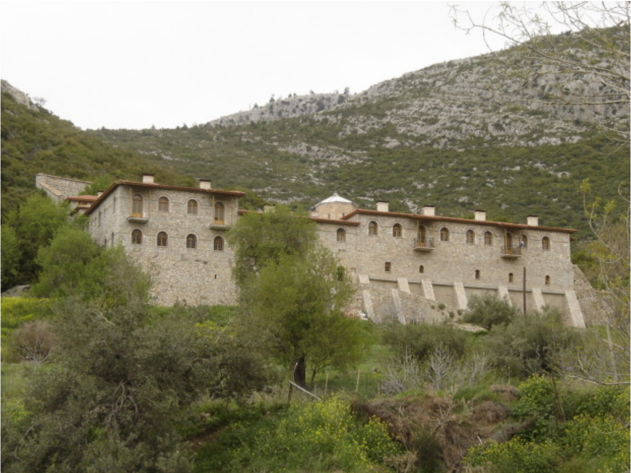
Η νότια πλευρά της Μονής
