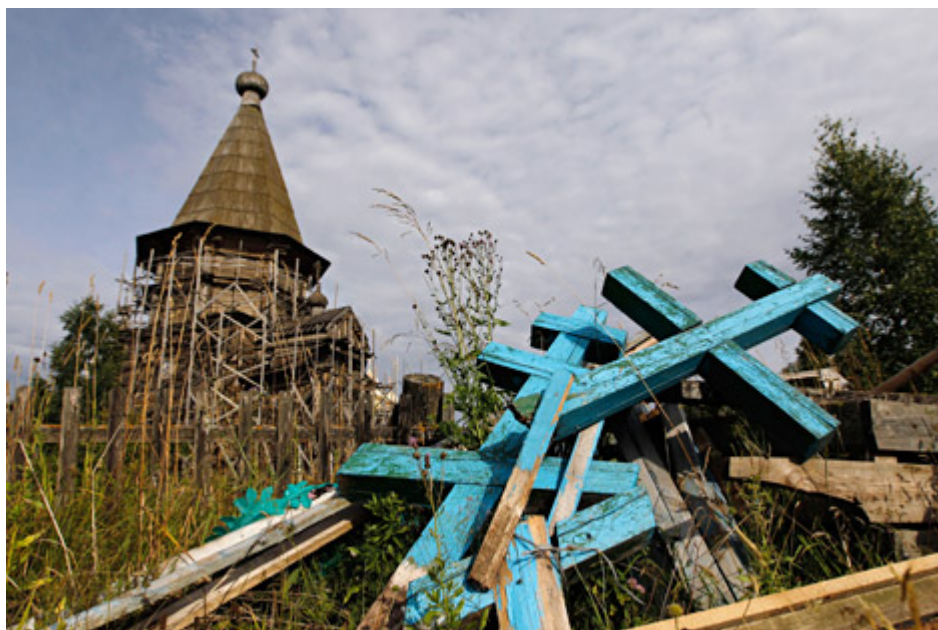
Εκκλησία της Μεσιτείας του αρχιτεκτονικού σύνολου των ξύλινων εκκλησιών XIII αιώνα στο χωριό Λιάντινι (Περιφέρεια Κάργκοπολ). Πηγή: Alexey Kudenko / RIA Novosti
