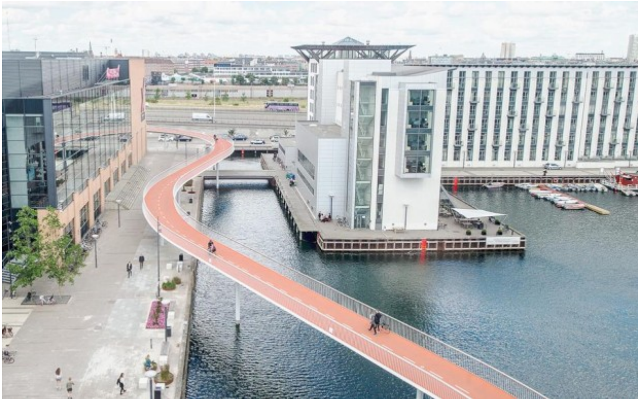
Το Ποδηλατικό Φίδι είναι μια υπερυψωμένη γέφυρα χρώματος πορτοκαλί, μήκους 235 μ. και πλάτους 4 μ. με δύο ποδηλατολωρίδες και αρκετά ήπια κλίση.
