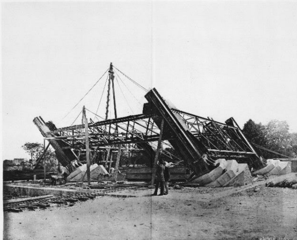
Commencement du montage métallique de la pile 15 e , 12 mètres carrés.
