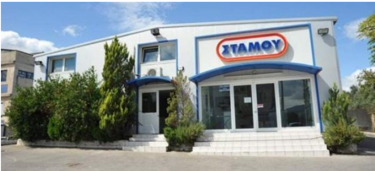
Από τις εγκαταστάσεις της γαλακτοβιομηχανίας Στάμου
