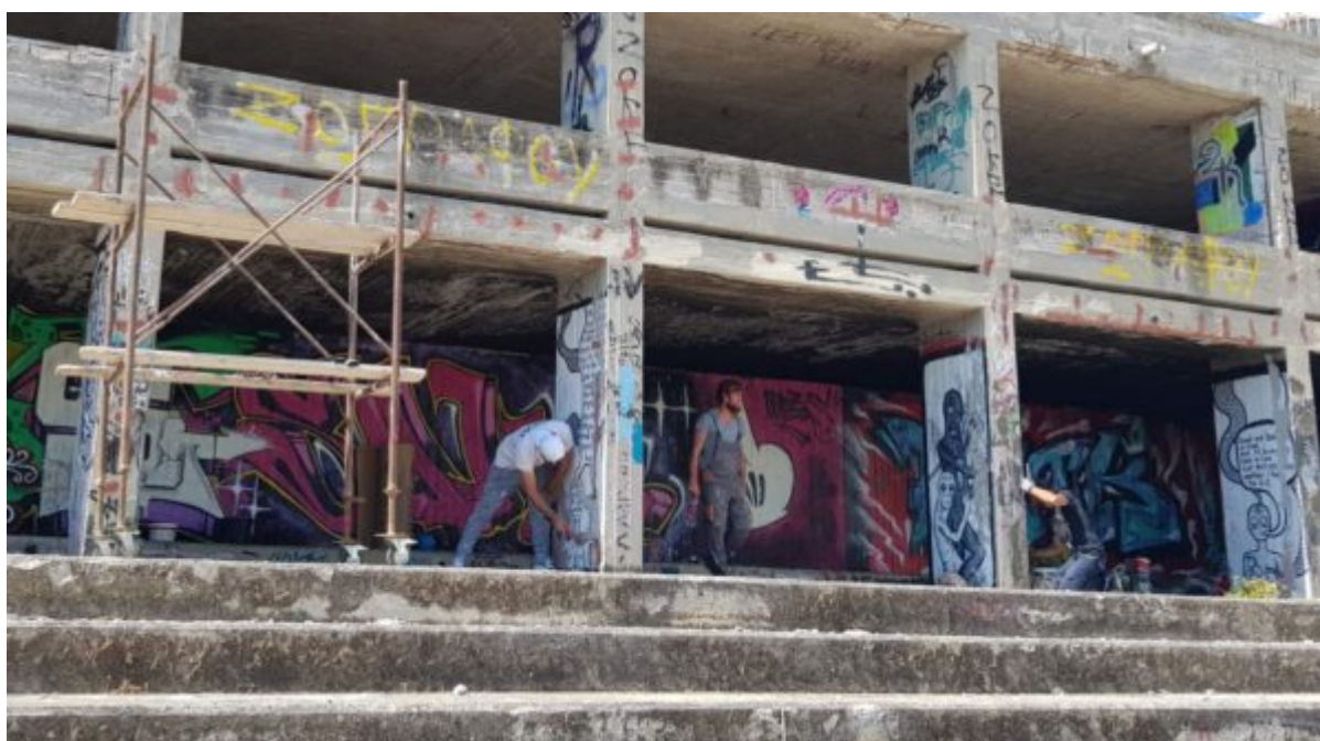
Το υπαίθριο αμφιθέατρο πριν την έναρξη των εργασιών
