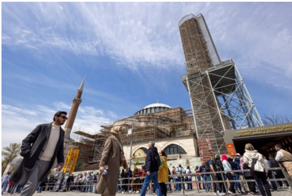
Σκαλωσιές στο εξωτερικό της Αγίας Σοφίας - Φωτ.: Reuters
