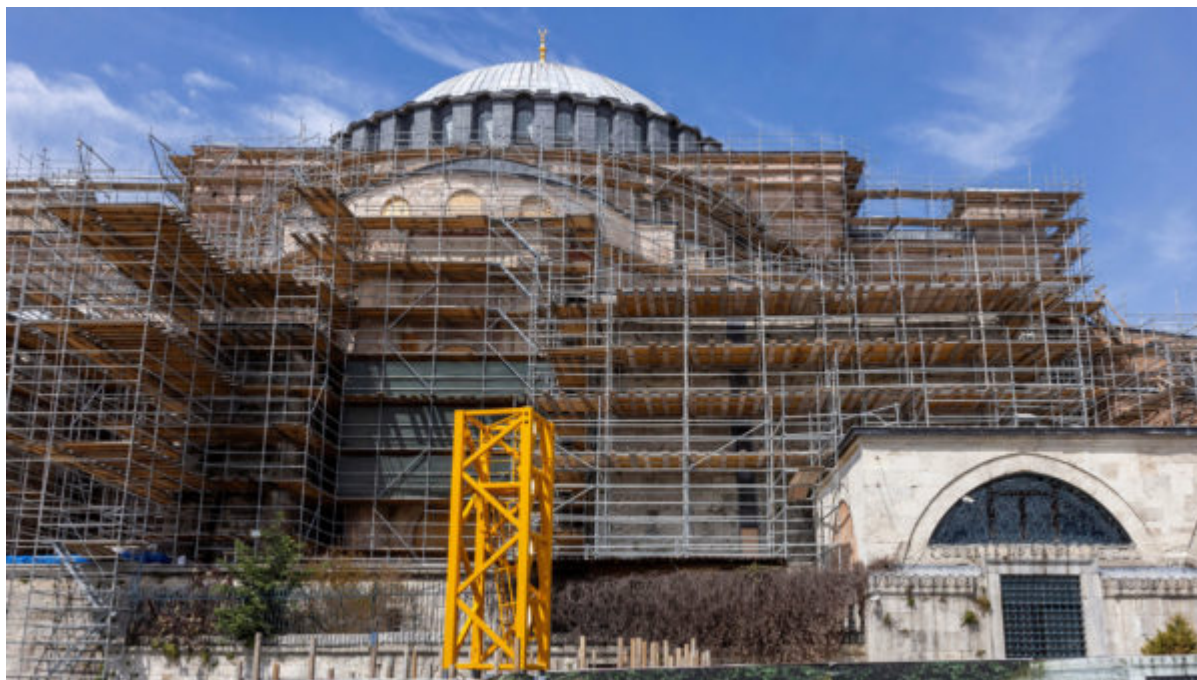
Εργασίες αποκατάστασης στο εξωτερικό της Αγίας Σοφίας - Φωτ.: Reuters
