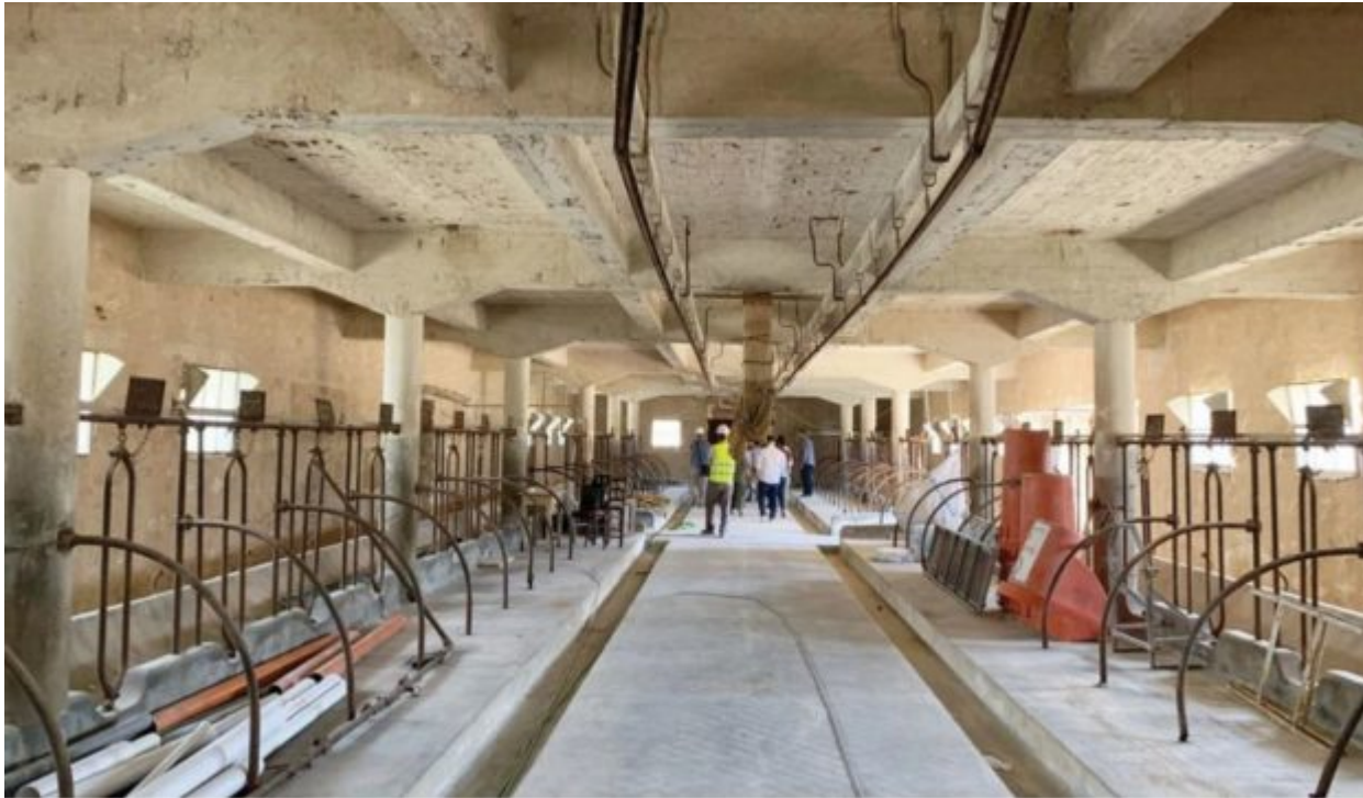
Εργασίες αποκατάστασης στο νέο βουστάσιο
