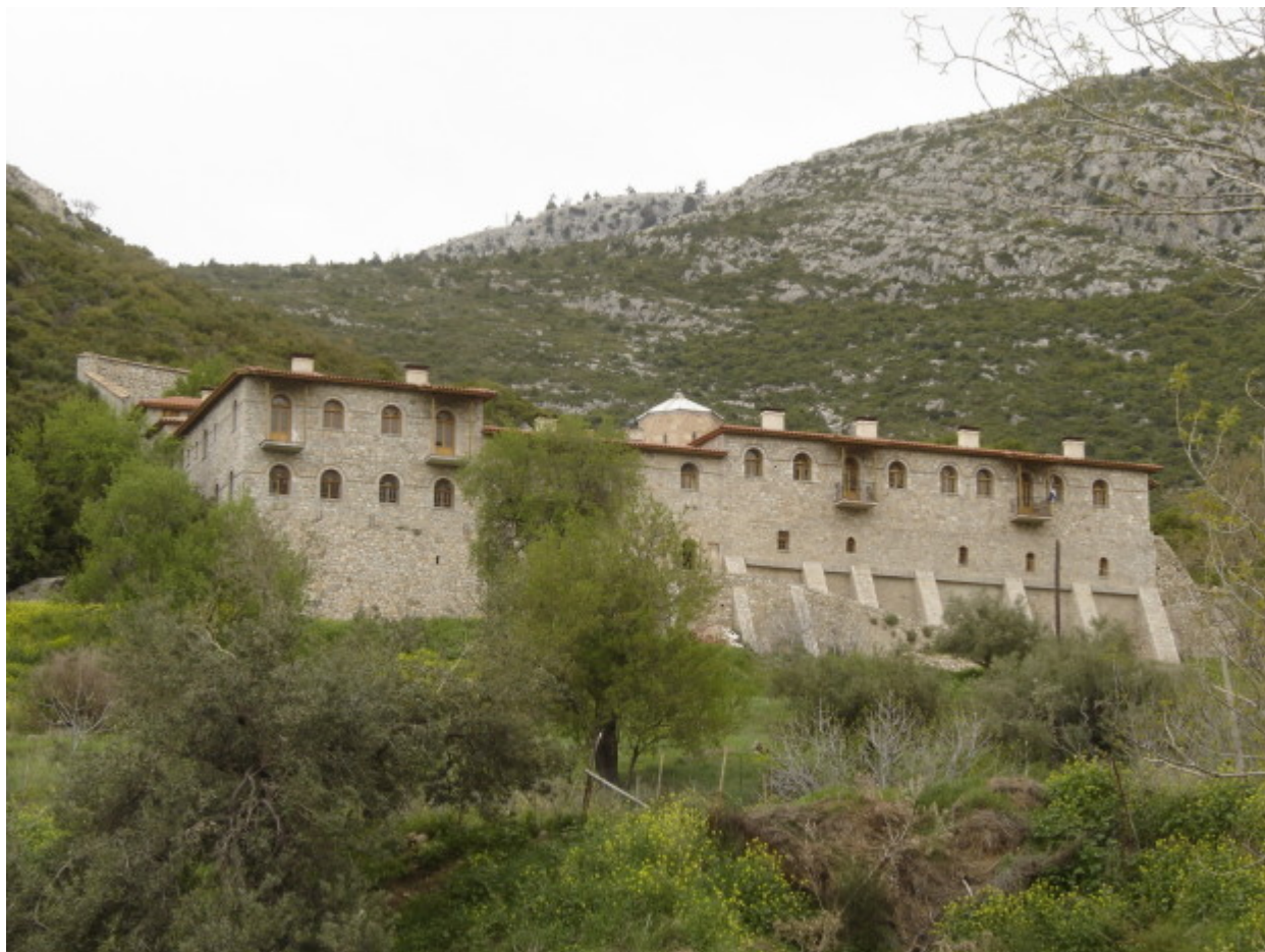
Η νότια πλευρά της Μονής
