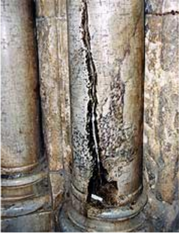
Η σχισμένη (ΟΧΙ ΡΑΓΙΣΜΕΝΗ) και μαυρισμένη Κολόνα
